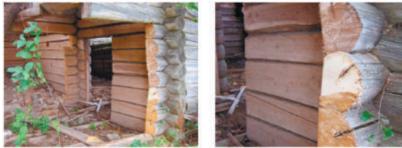
Рис. 3. Осмотр старых домостроений и заготовка образцов ретродревесины
