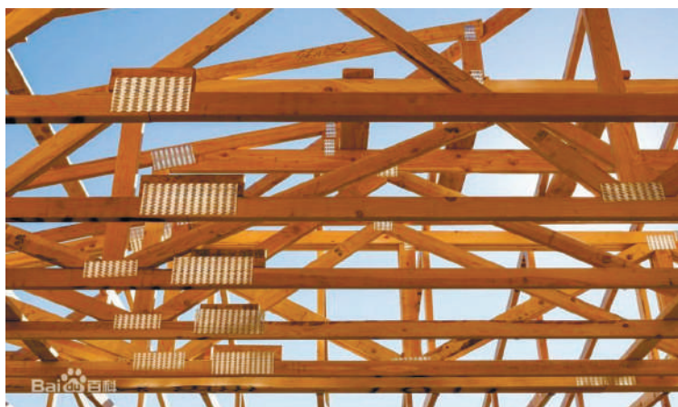
Деревянная стропильная крыша
