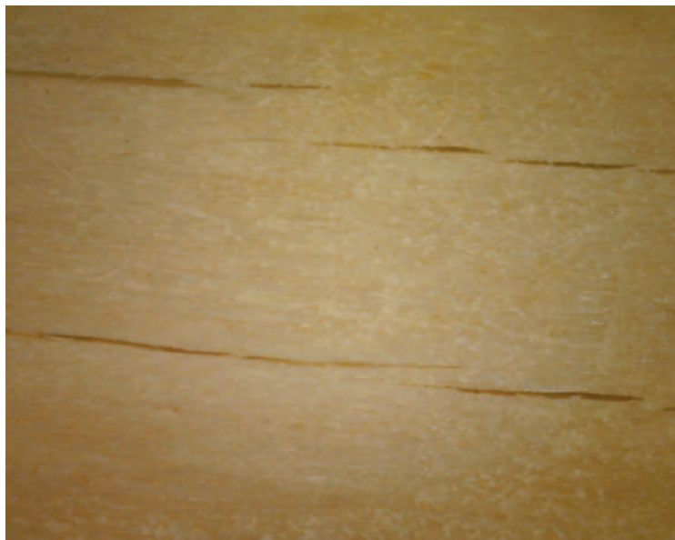
Рис. 3. Трещины после 1-го цикла замачивания
